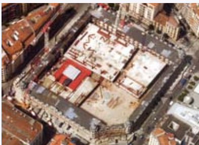
Vue aérienne du chantier de construction (Mai 2006)
