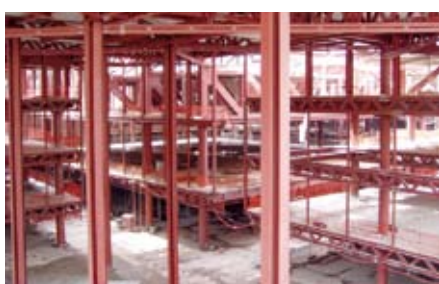
Structure en acier du hall d'entrée principal face aux cubes
