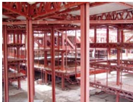
Staalconstructie in de ingangshal vóór de kubussen.
