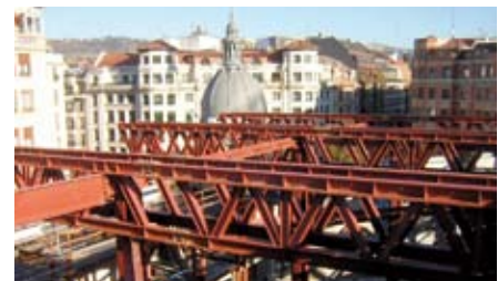
Aan de rand van de vakwerkliggers die het atrium overspannen bevindt zich een uitkraging.
