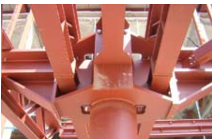
Boutverbindingen in een kolom die is geplaatst in een hoek tussen twee kubussen.
