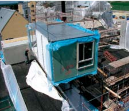
(Haut) Installation de modules et façades achevées
