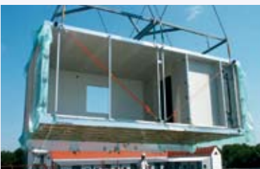
Module OpenHouse en cours d'installation, montrant l'utilisation de modules à côtés ouverts avec des poteaux supplémentaires provisoires
