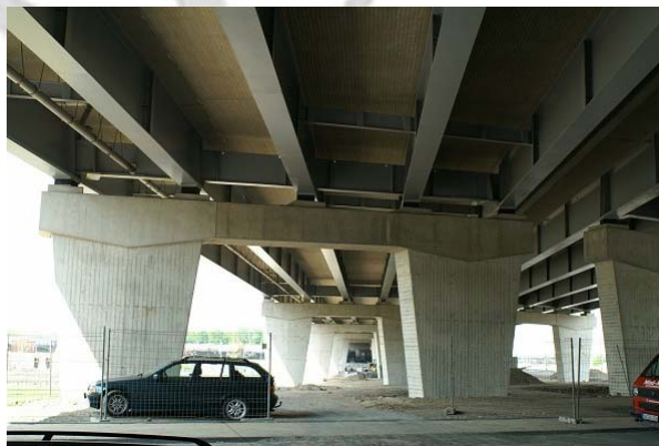
Hafenbahn Brücke, Duisburg N. Janberg (Structurae.de)
