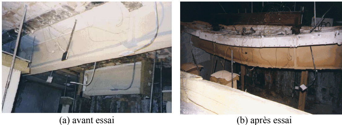
Figure 13 Déformation des poutres chargées soumise à l'exposition de feu
