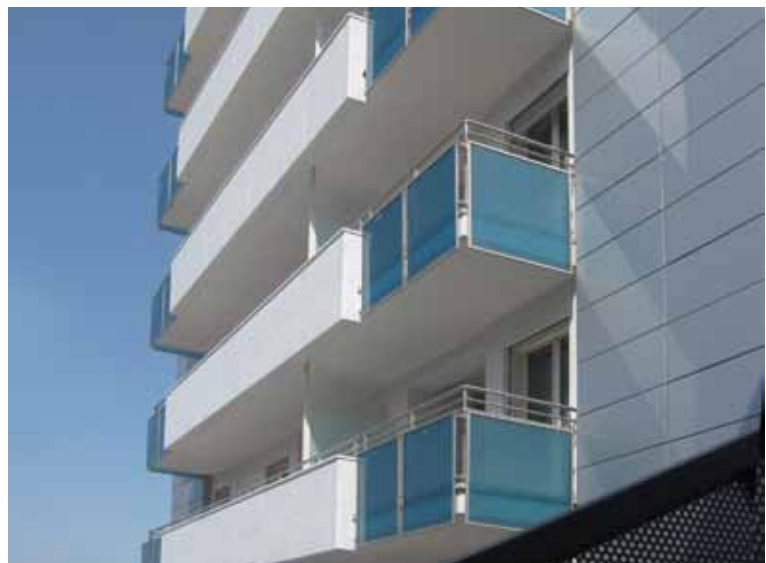
L'acier inoxydable prélaqué peut être plié – par exemple pour réaliser des éléments de façade. Photo : Centro Inox, Milan (I)
