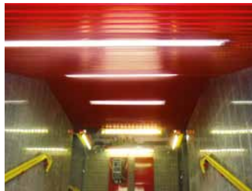
Une finition rouge séduisante pour l'acier inoxydable de la station de métro Piazzale Carlo Maciachini à Milan. Photo : Centro Inox, Milan (I)
