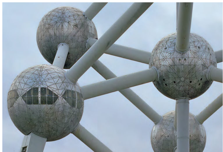
Meer dan 40 jaar later had de aluminium bekleding haar glans verloren, en waren de dichtingen gaan lekken.
