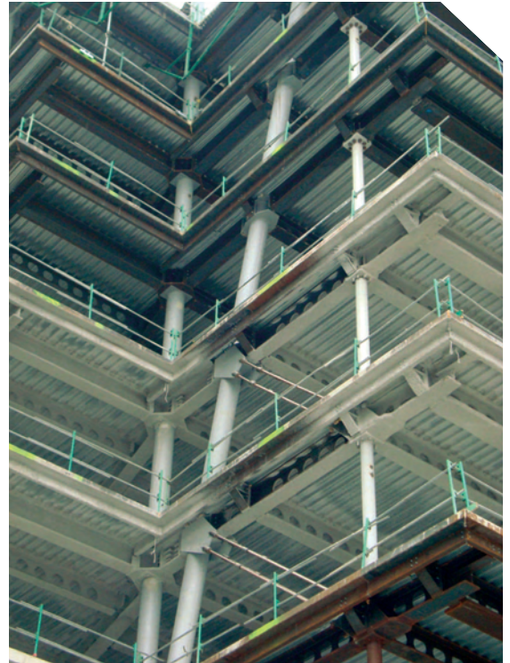
Façade nord en chantier, où l'on voit le système de planchers suspendus avec le bracon et la suspenste.
