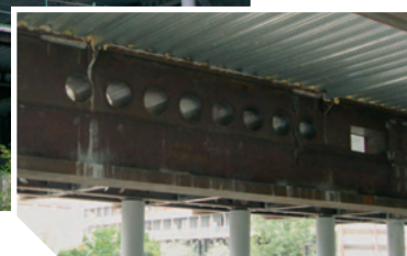
Méga poutre caisson en acier.
