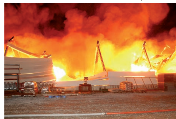
Buitenwanden die naar binnen toe bezijken (bron: SRI Charleroi)_Illustration de l'effondrement vers l'intérieur de parois extérieures (source : SRI Charleroi)
