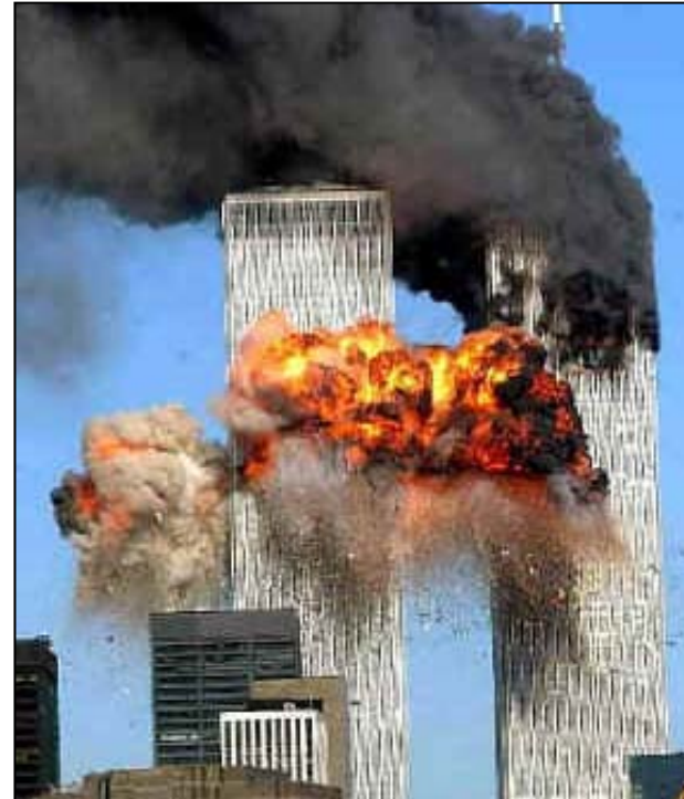
Intégrité structurale partielle
