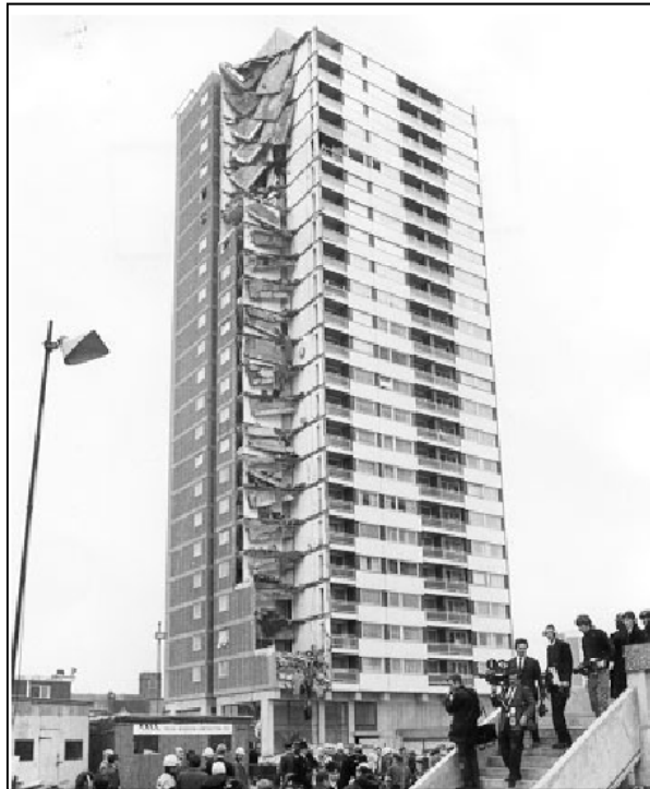
Pas d'intégrité structurale
