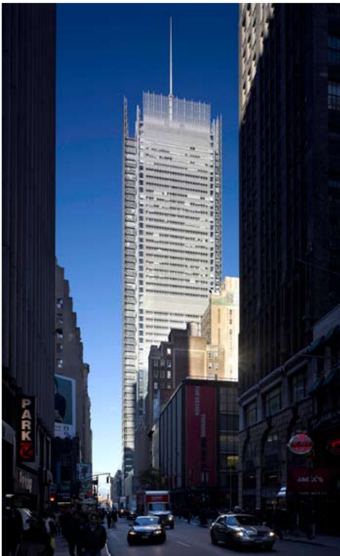
Meer dan 95% gerecycled staal werd gebruikt voor de geheel zichtbare staalstructuur bij de New York Times Building, ontworpen door Renzo Piano (zie ook info_steel 15) _Plus de 95% d’acier recyclé est utilisé dans la structure métallique entièrement apparente du New York Times Building conçu par Renzo Piano (info_steel 15)
