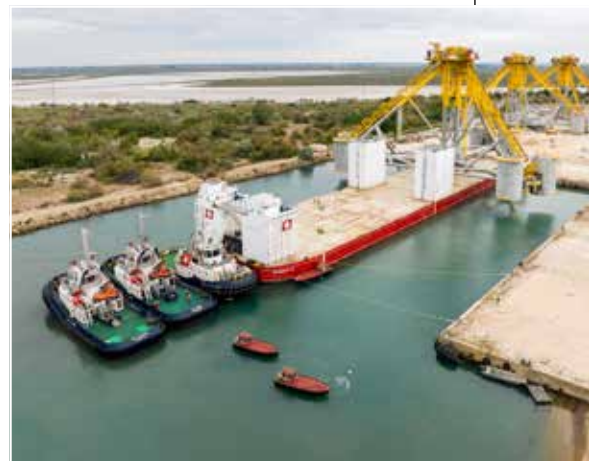
De load out (de levering) van de gigantische structuren op een semi-submersible. La livraison des structures géantes sur barges semi-submersibles
