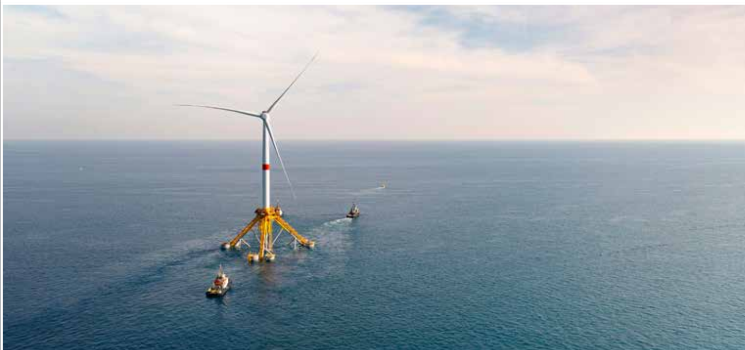
Slepen van windturbines op zee _Remorquage des éoliennes en mer
