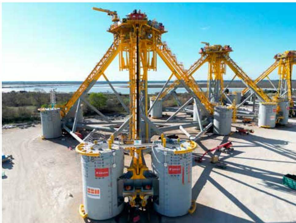
Assemblage van de drijvende funderingen op de site van Eiffage Métal. Assemblage des fondations flottantes sur le site d'Eiffage Métal
