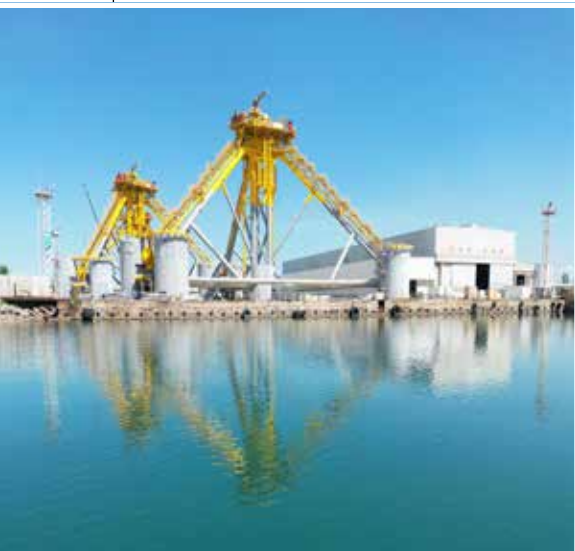
Assemblage van de drijvende funderingen op de site van Eiffage Métal. Assemblage des fondations flottantes sur le site d'Eiffage Métal
