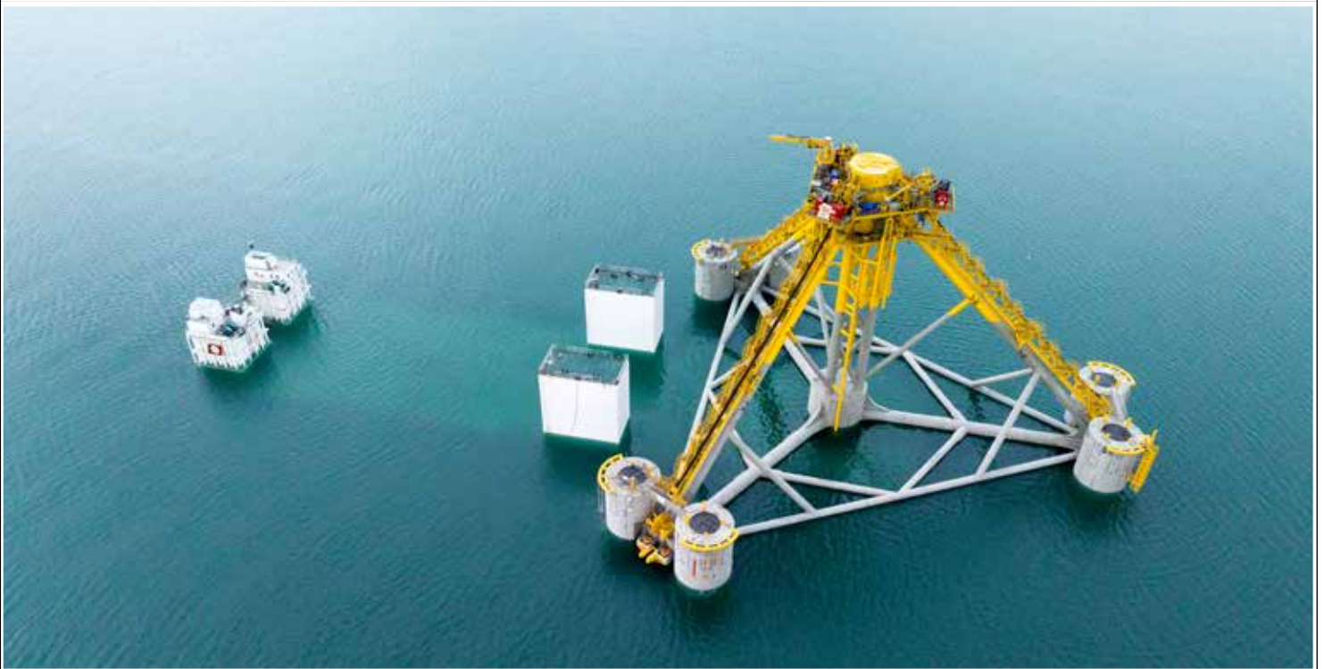
Transport op de semi-submersible in de haven van Marseille-Fos voor de montage van de windmolen _Transport sur la barge semi-submersible dans le port de Marseille-Fos pour le montage de l'éolienne
