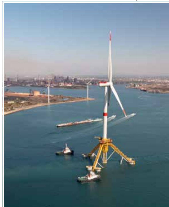
Slepen van windturbines op zee _Remorquage des éoliennes en mer
