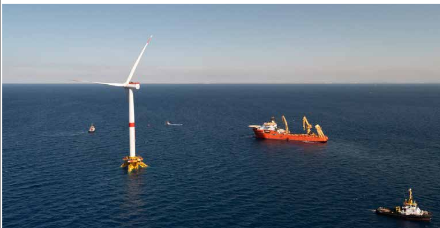
De eerste drijvende windmolen wordt geïnstalleerd_La première éolienne flottante est installée
